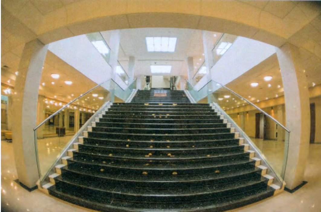
Ил. 3. Концертный зал им. А.М. Каца, главный лестничный марш вестибюля, лабрадорит. Снимок из архива кафедры строительного производства НГАХА
