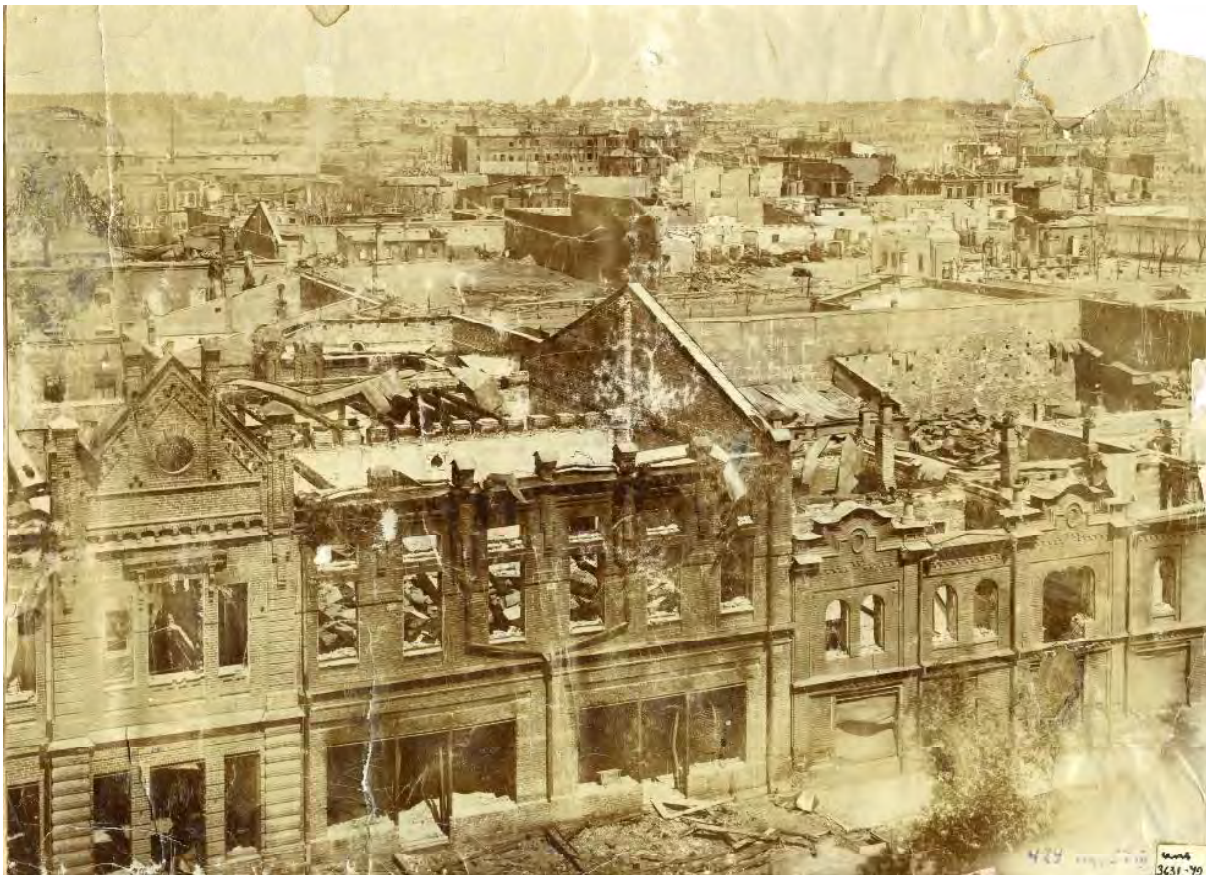
Ил. 3. Здание городской управы на ул. Большая Тобольская после пожара. Барнаул, 1917 г. АГКМ ОФ 429
